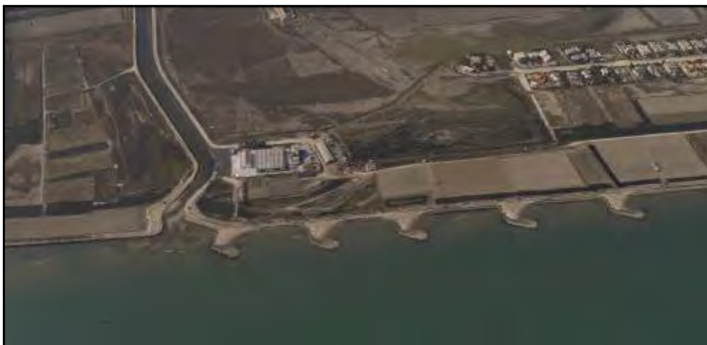
Le opere di difesa costiera in corrispondenza del villaggio Ippocampo
