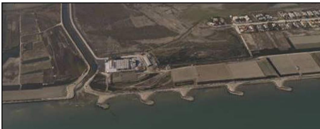
Le opere di difesa costiera in corrispondenza del villaggio Ippocampo
